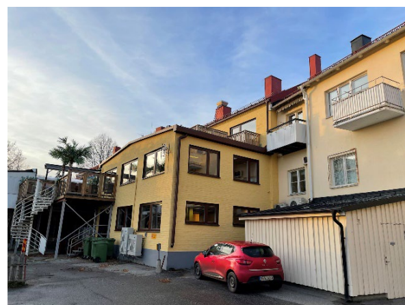
Tillbyggnad intill Koppardosan 2A
