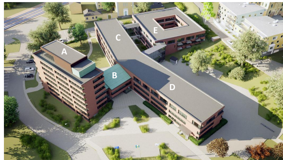
Figur 3. Vy på befintlig byggnad med föreslagna tillbyggnader. Bokstäverna A-E visar benämning på de olika huskropparna. Volymiskiss gjord av Archus.
