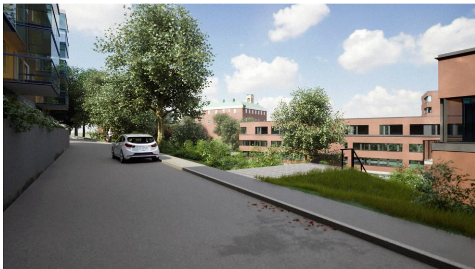
Figur 11. Vy 6, från Nanna Svartz gata och befintliga bostäder i öst mot slottet och befintlig byggnad med tillbyggnader.
