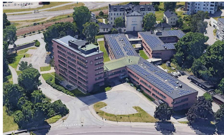
Figur 34. Befintlig byggnad. Vy från Google earth.
