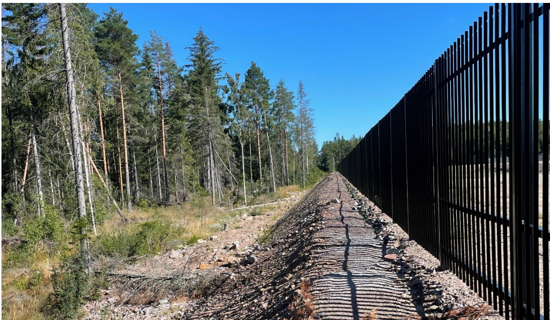
Figur 4. Planområdets nordvästra del, sett från väster, som planläggs för att åstadkomma en anpassning till hur marken används. Staketet skiljer redan utbyggd anläggning mot omgivande skogsmark mot norr.
