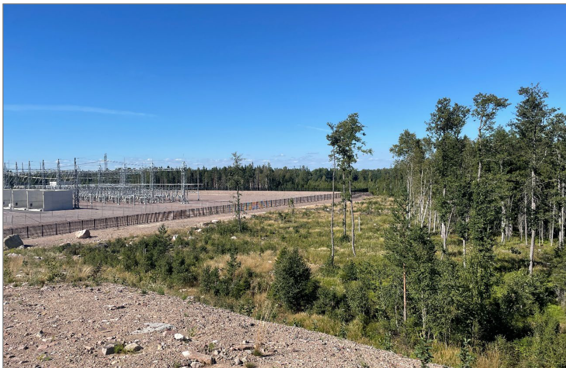
Figur 3. Del av planområdet och befintlig transformatorstation som avses utvidgas, sett från sydost.
