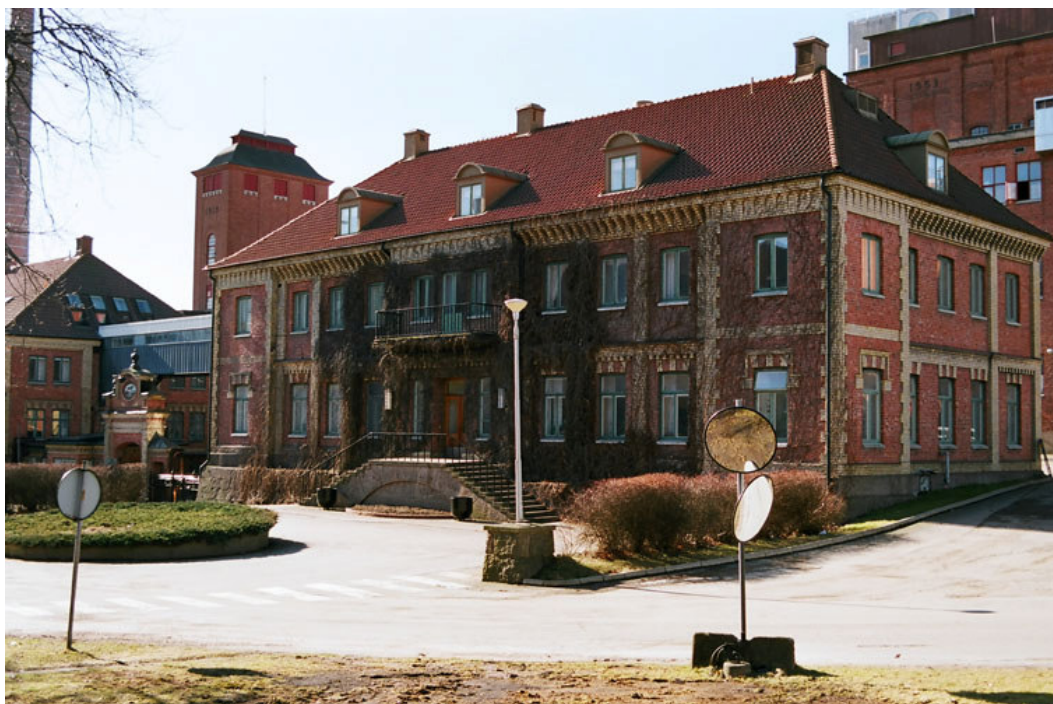
Huvudkontoret från norr. Byggnaden fick sitt nuvarande utseende vid en ombyggnad 1942. Foto Lars Bergström 2009.
