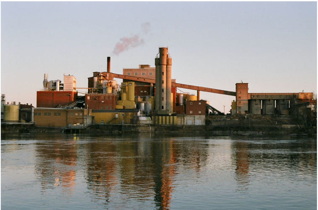
Pappersbruket från norr med bl a syratornet och renseriet med dess betongsilos och bryggan med transportör till kokeriet. Foto Lars Bergström 2009. Jämför med ritningen på sid 24.
