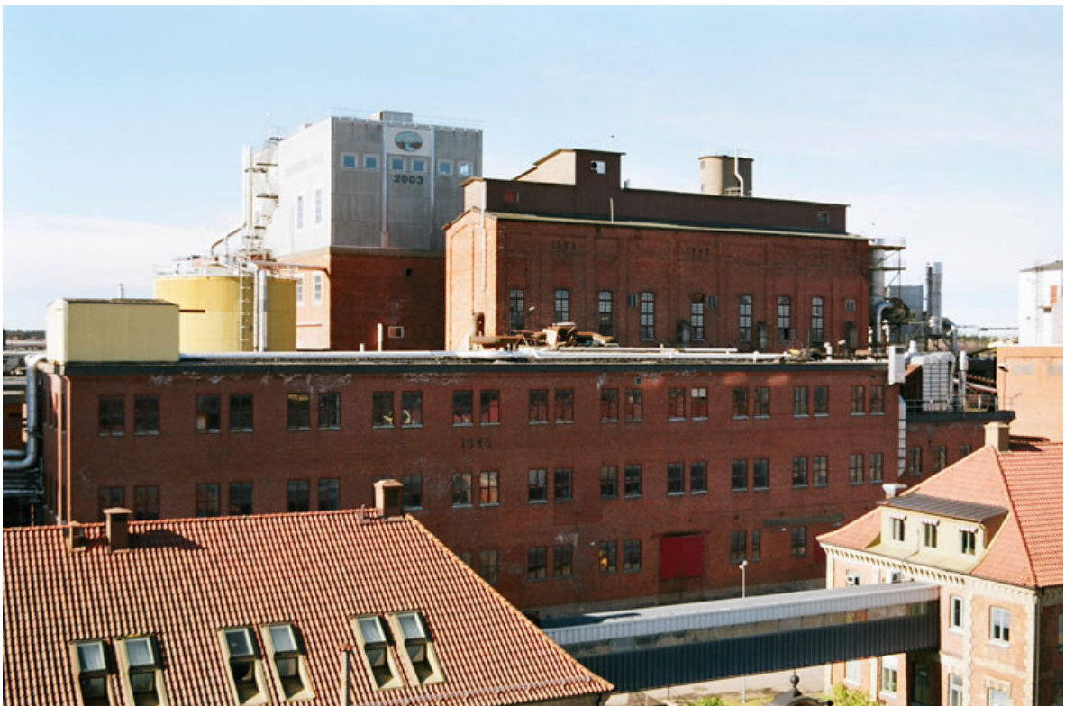
På taket av blekeriet finns påbyggnaden för massablekning från 2003. I förgrunden taket på tekniska kontoret och dess förbindelse till huvudkontoret. Bakom dessa syns byggnader för massaupptagning och kokeri. Foto från öster, Lars Bergström 2009.
