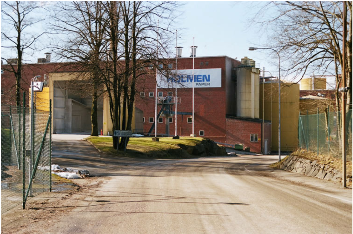
Del av byggnaden som rymmer PM5 vid infarten till bruksområdet från öster. Foto Lars Bergström 2009.
