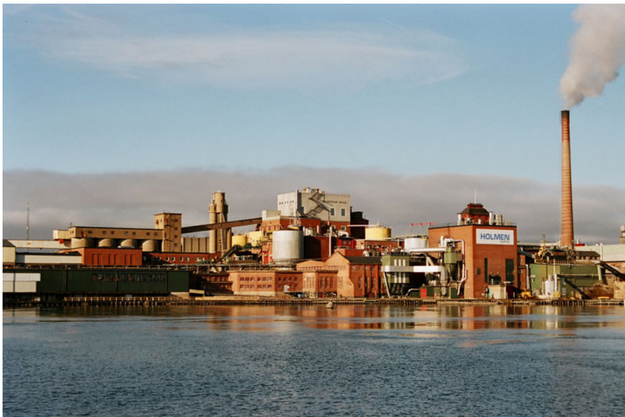
Pappersbruket från söder. T v i bild syns delar av det stora magasinet, sjömagasinet, från 1937 med fasad av grön plåt . Till höger i bild fabrikskorsten och ångcentralen (med företagsnamnet Holmen). Foto Lars Bergström 2009.
