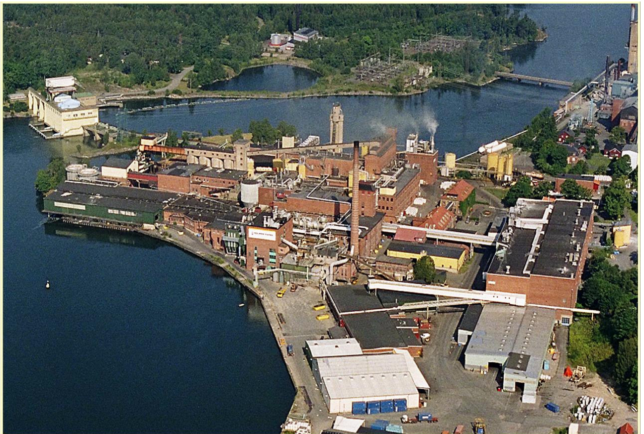
Pappersbrukets och vattenfalls kraftstation från söder ca 2000. På halvön finns brukets äldsta delar huvudsakligen med byggnader för massatillverkning och den tidigare papperstillverkning. Till höger och närmast i bild syns brukets yngre delar som utgör tydliga tillägg till den äldre mer täta och komplexa byggnadsmassa. Foto Holmen Paper AB.
