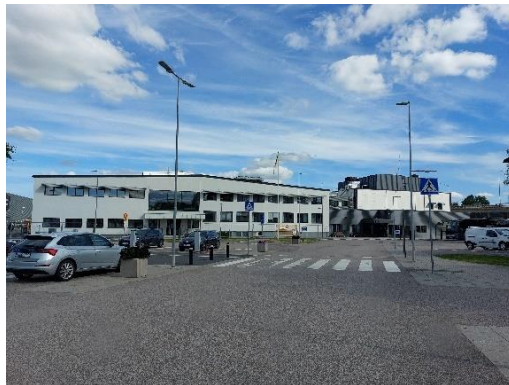
Bild 28 från Ikea 4 mot en kontorslokal
