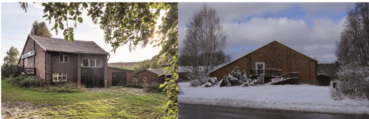
Figur 5. Bild på lokstallet från två olika håll.
