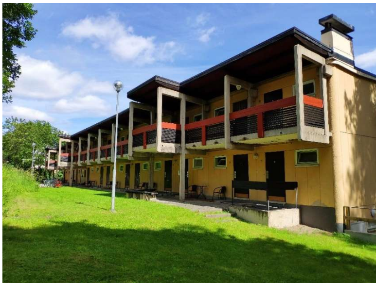
Ralph Erskines loftgång på Rullstenen 15
