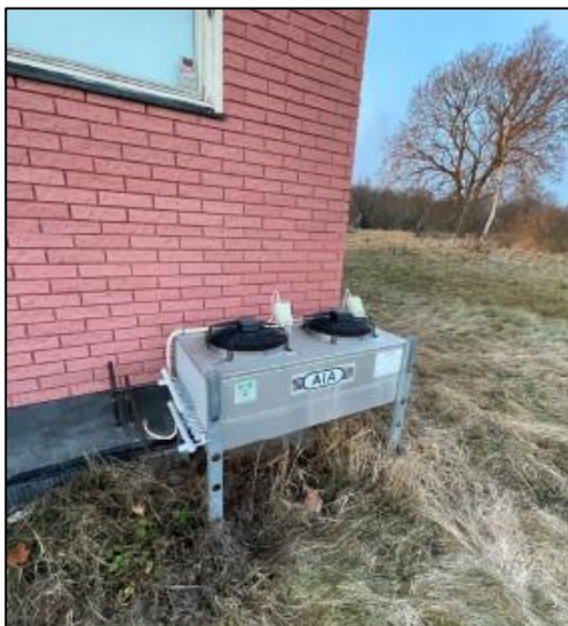
FIGUR 6. KONDENSORFLÄKT VID GOURMETKOMPANIET.
