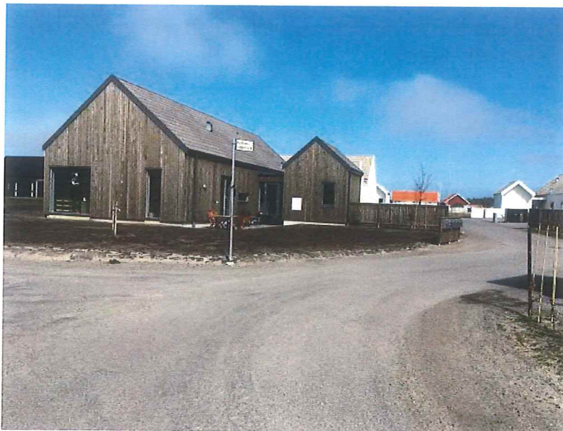
Bild från pågående genomförande av detaljplan L107.
