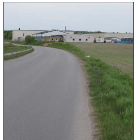
Varolavägen mot väster
