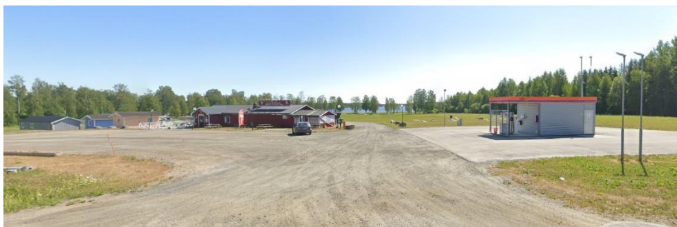
Bilden visar tankstationen läst österut, restaurang- och receptionsdelen i mitten samt stugorna längst västerut.
