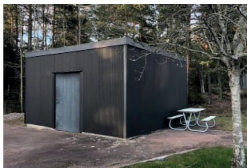
Förrådsbyggnad, inom planområdet
