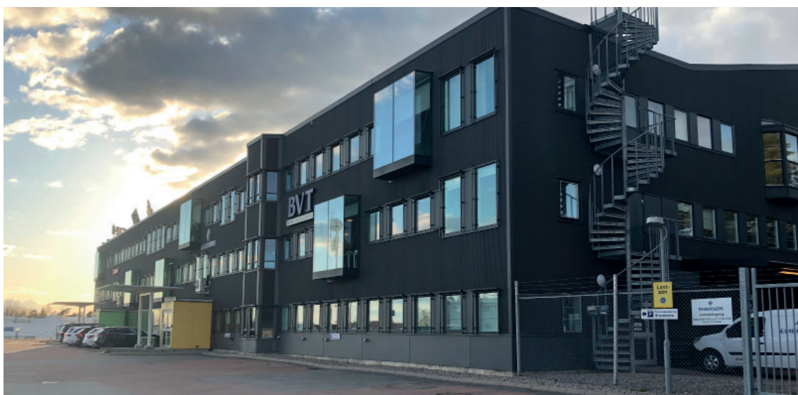
Befintlig kontorsbyggnad inom planområdet
