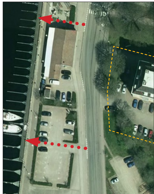
Befintlig bebyggelse och inhägnad parkeringsplats ligger mellan planområdet och strandkanten.
