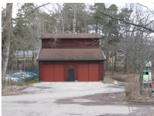
Sopsugsanläggningen vid Smedvägen
