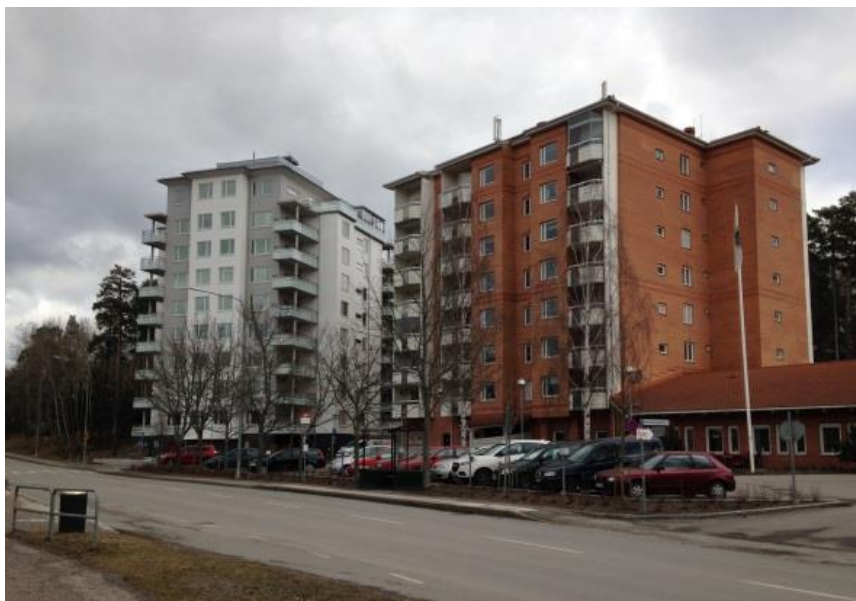
Bostadsbebyggelse vid Kallhällsleden
