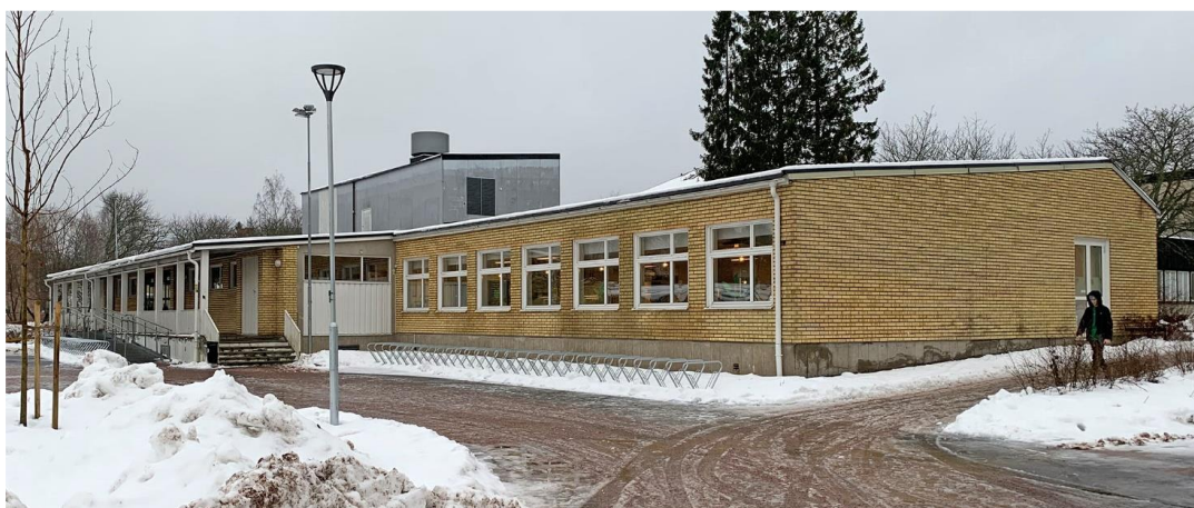
Figur 25. Nynässkolans befintliga matsal som avses rivas. Foto från byggnadsinventering (Sweco, 2021).
