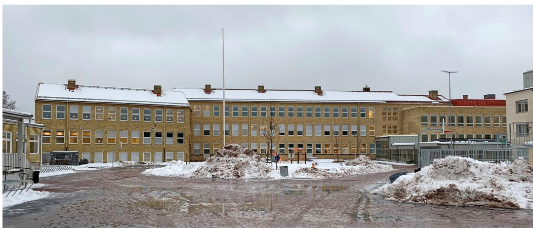
Figur 21. Nynässkolans äldre del, sedd från söder. Den nyare delen till höger samt befintlig matsalsbyggnad till vänster. Foto från byggnadsinventering (Sweco, 2021).
