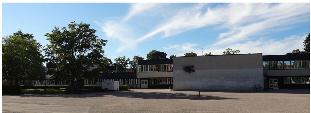
Figur 17. Foto som visar Kulturskolans fasad mot skolgård. Foton från byggnadsinventering (KMW, 2014).
