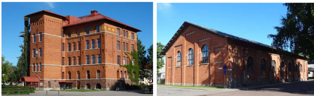
Figur 12 och 13. Borgarskolans huvudbyggnad till vänster och den äldre gymnastikhallen till höger. Foto från byggnadsinventering (KMW, 2014).
