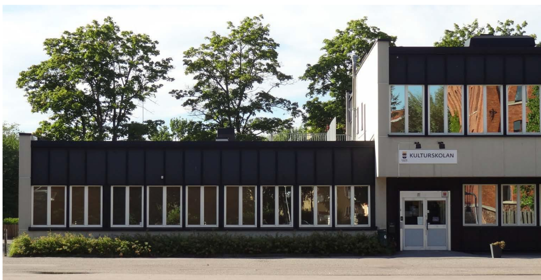
Figur 18. Foto som visar del av Kulturskolans fasad mot skolgård. Foton från byggnadsinventering (KMW, 2014).
