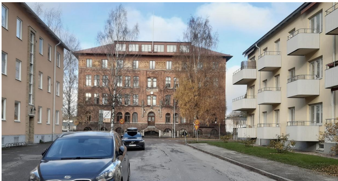
Figur 14. Foto som visar Borgarskolan i fonden mot Byggmästargatan (Gävle kommun, 2021).
