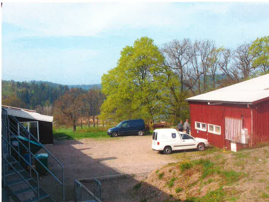
Förrådsbyggnad som rivs
