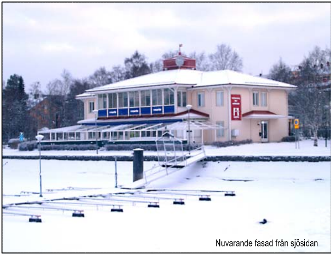
Nuvarande fasad från sjösidan
