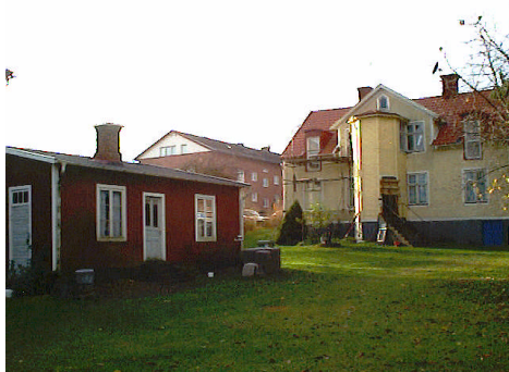
Befintlig huvudbyggnad och uthus på fastigheten Sågen 3, sett från gården.
