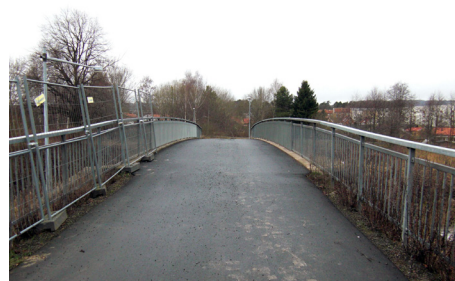
Gång- och cykelbron söder om planområdet.
