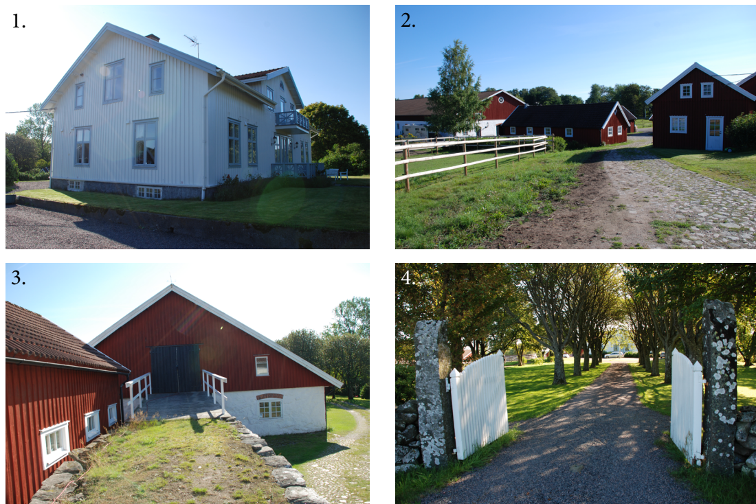
1. Mangårdsbyggnaden. 2. Övrig värdefull bebyggelse på gården. 3. Ekonomibyggnaden med murad ramp till höskullen. 4. Allén längs uppfarten till mangårdsbyggnaden.
