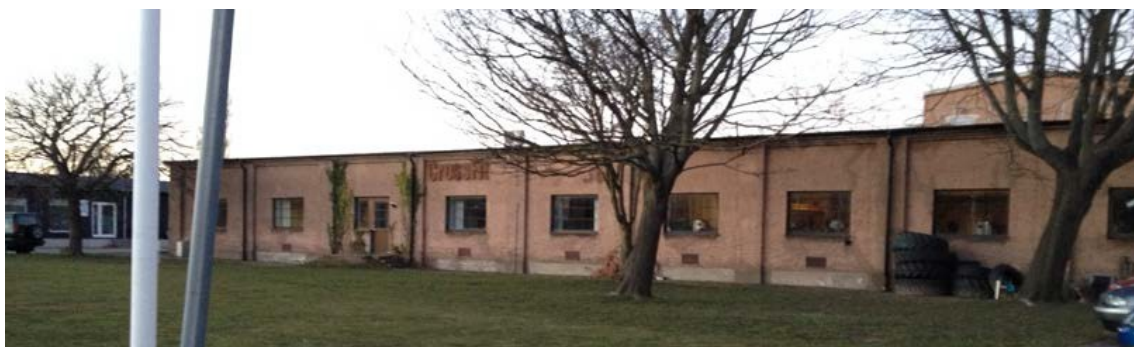
Röret 12. Fasad mot sydväst.
