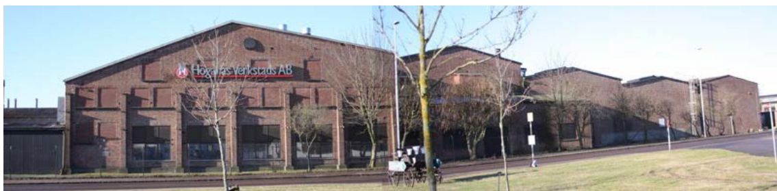
Röret 8. Fasad mot nordost. De tre fasadpartierna till vänster utgör fasad för Röret 8. Resterande två fasadpartier utgör Röret 6. Bilden är ett fotomontage.
