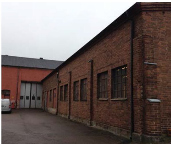
Röret 8. Mönstermurningar, listverk och murade kontreforer är genomgående för byggnadens karaktär.
