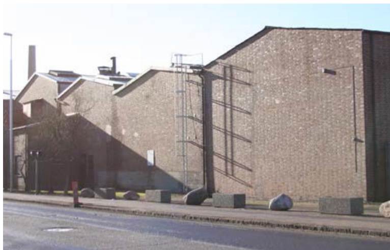
Röret 6. Fasad mot nordost. De två fasadpartierna till höger utgör Röret 6.
