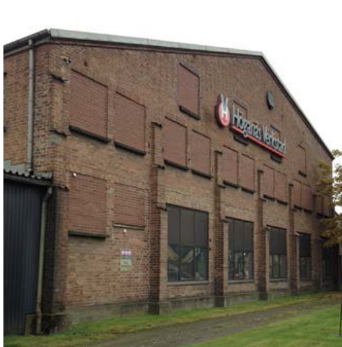
Röret 8. Mönstermurningar, listverk och murade kontreforer är genomgående för byggnadens karaktär.
