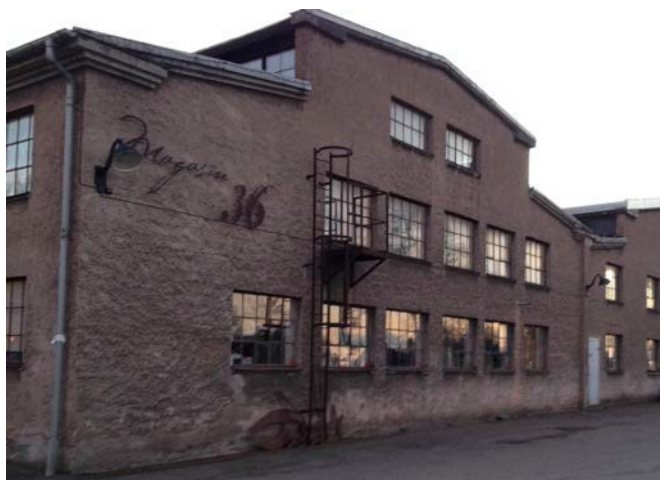
Röret 12. Gavelfasad mot nordost. Smårutiga gjutjärnsfönster, murade listverk och grov rödgul puts.
