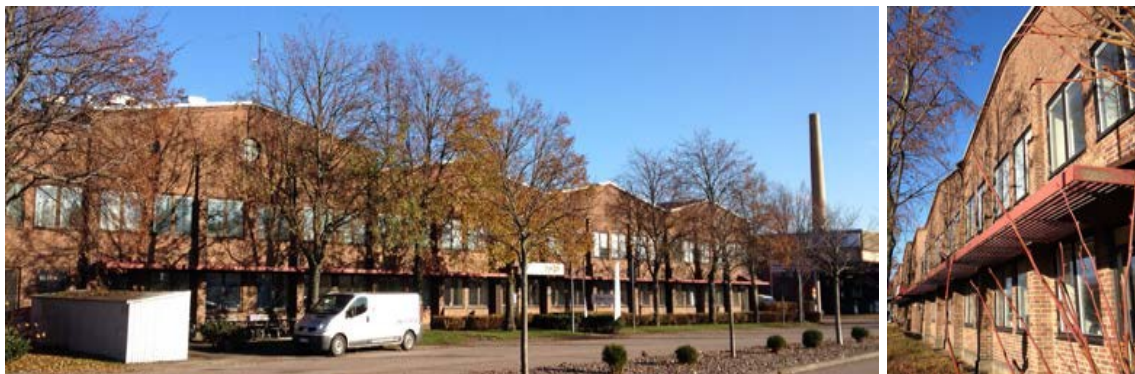
Röret 8. Fasad mot sydväst.
