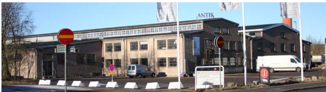
Röret 12. Gavelfasad mot nordost. Karaktäristisk takform med överljusinsläpp.
