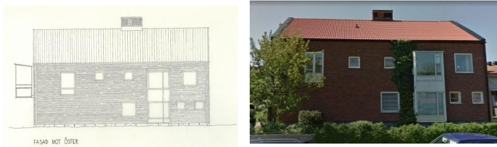
Bilden till vänster visar originalritningen av Dellbornvillan från 1955. Bilden till höger är byggnaden som den ser ut idag.
