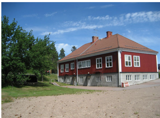
Hus C från sydväst
