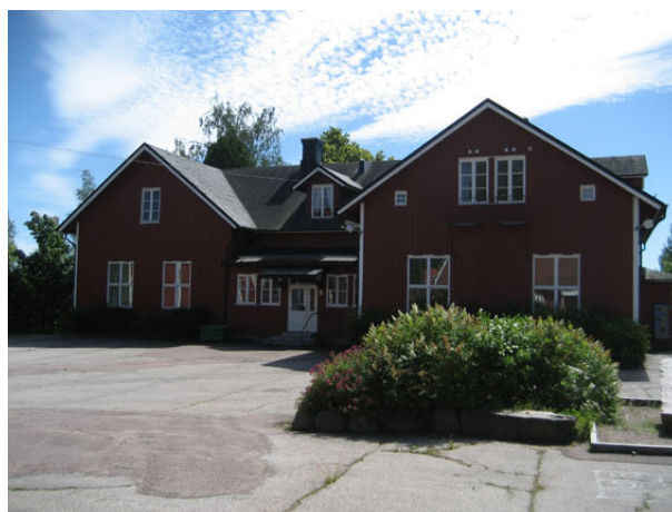
Hus B från norr
