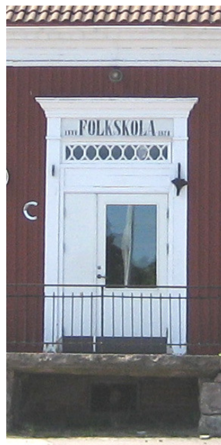
Entrén har högt kulturhistoriskt värde
