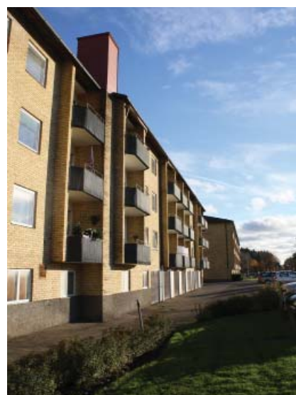
Balkongfronter av sinuskorrugerad plåt i koppar
