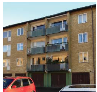
Balkongräcken och tvåluftsfönster i det ursprungliga området går igen i de moderna punkthusen
