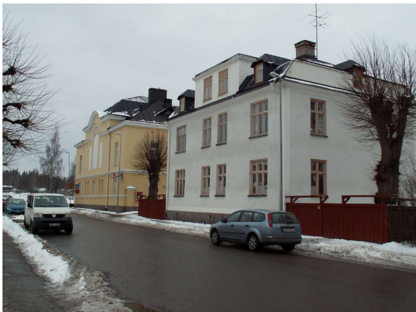
Byggnader vid Nygatans nordöstra del
