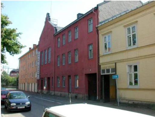
Befintligt hus mot Mariedalsgatan.
