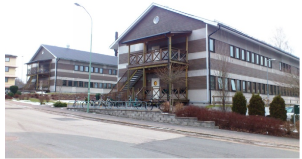
Befintlig bostadsbebyggelse. Huvudentré finns på gavelfasad mot Flintgatan. Varje plan har en egen entré. En utomhustrappa på gavelfasad går till husets andra våning. Husen saknar hiss och inomhustrappa.
