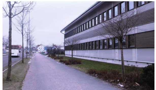
Långfasad för befintligt studenthus ligger parallellt med Jönköpingsvägen. Gång- och cykelvägen utmed Jönköpingsvägen är en viktig gång- och cykelstråk i Värnamo stad.
