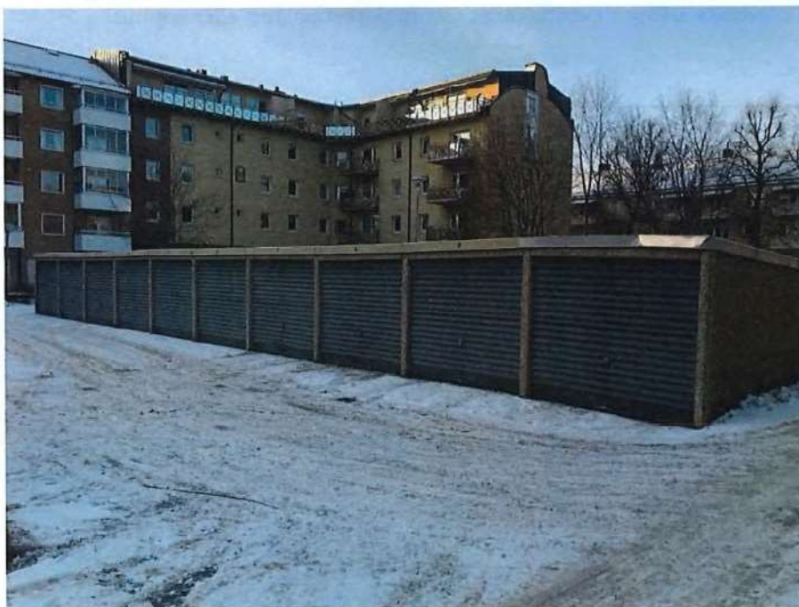
Bild: Befintlig garagelänga.
