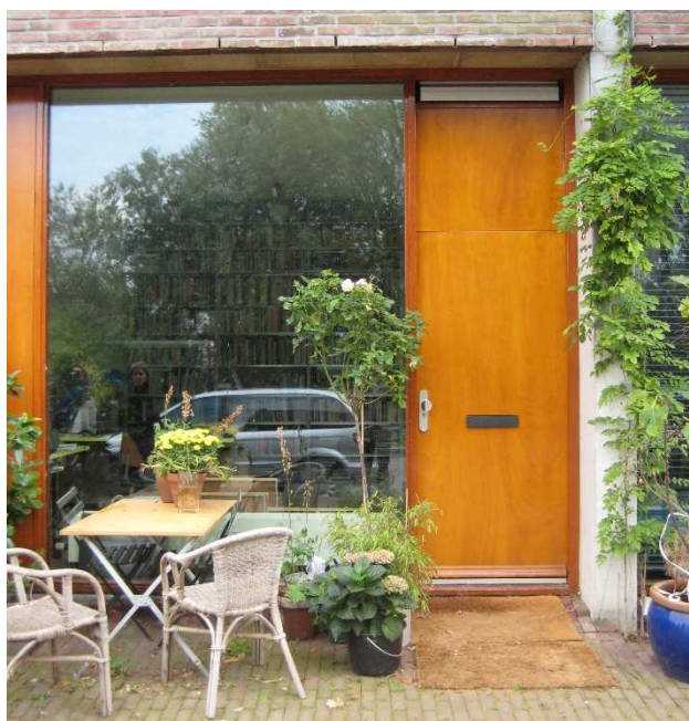
Entréparti med träinslag.
