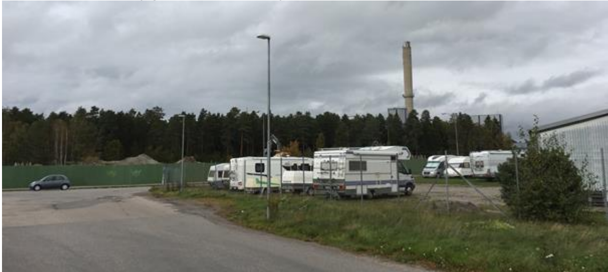
Industribebyggelse och kraftvärmeverkets skorsten, Katrineholms kommun, 2019
