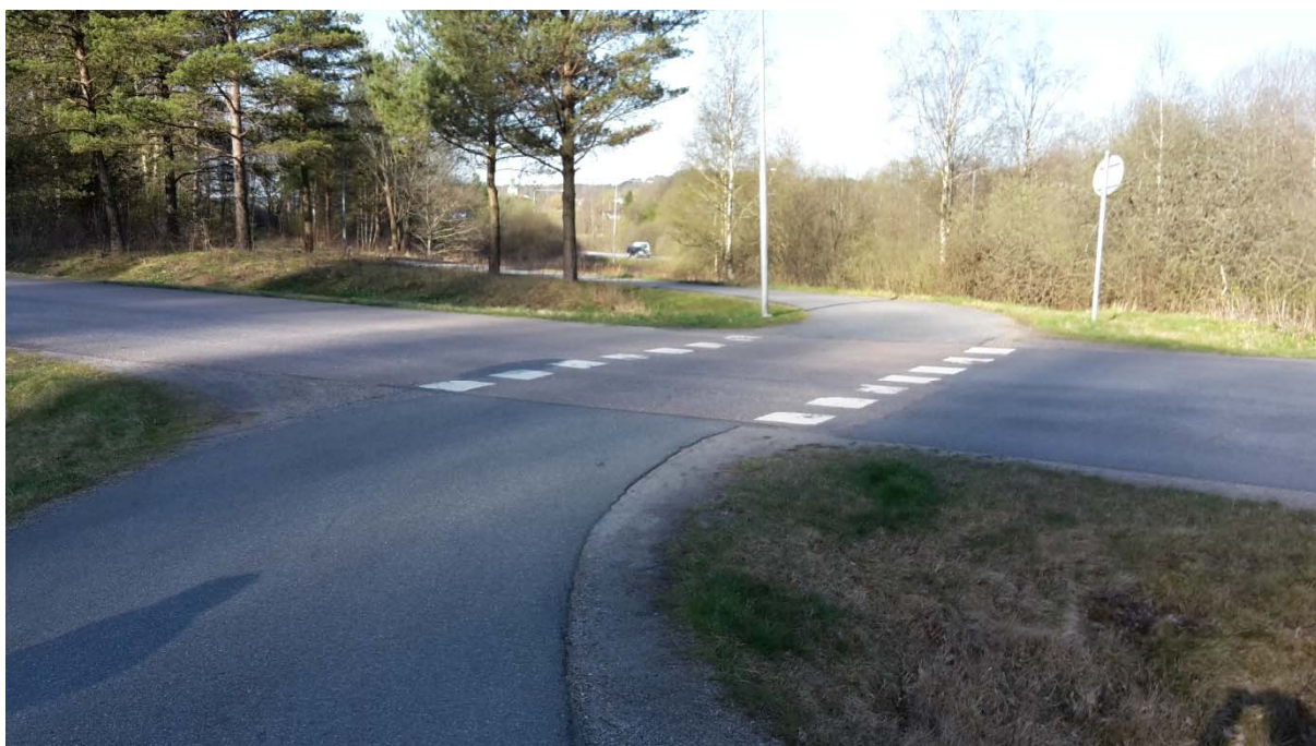
Befintlig cykelöverfart över Enekullsvägen.
