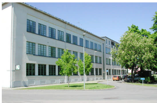
Västra Magasinsgatan från söder.
