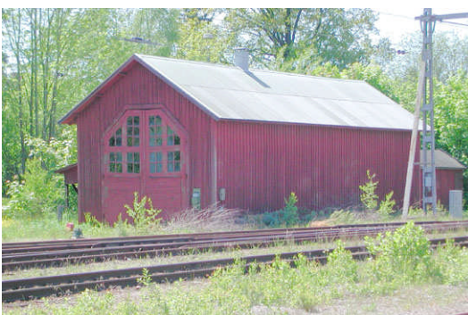
Lokstallet i den västra delen av järnvägsområdet.
