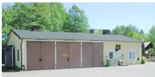
Byggnaden där taxiverksamheten håller till.
