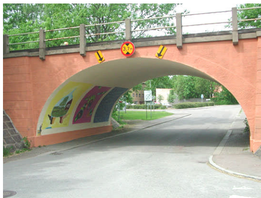
Tunneln på Tunnelgatan.
