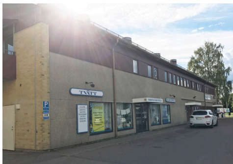
Den befintliga byggnaden
