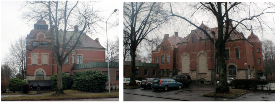
Tingshusets norra och västra fasad med sammanlagt fyra igenmurade fönster.
