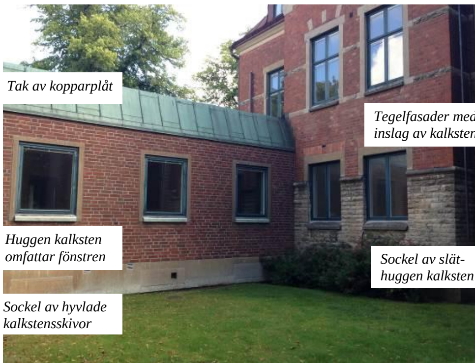
Tingshusets västra fasad samt tillbyggnaden uppförd på 1970-talet.
