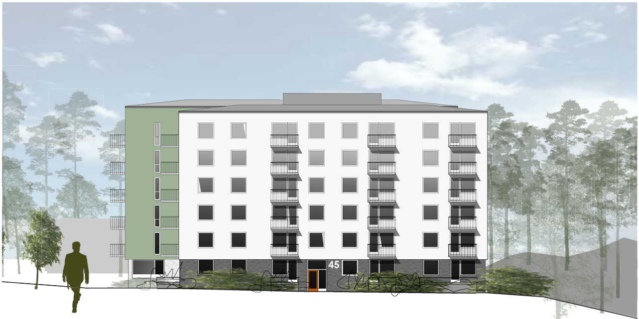
Norra 6-våningshuset, mot öster
