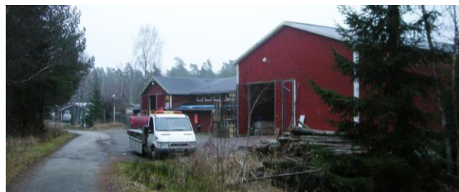
Bilderna visar pågående entreprenadverksamhet inom planområdet.
