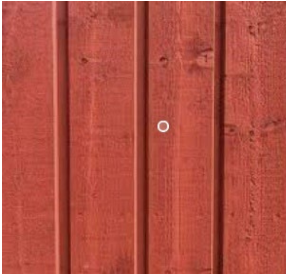
Materialbilder som visar rödfärg kulör NCS S 5040 Y80R, vilket ses på platsens komplementbyggnader idag, samt matt takpapp lagd med bandtäckning.
