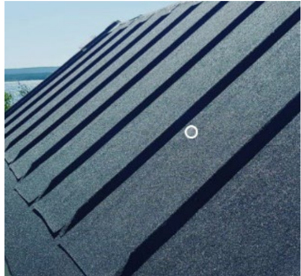
Materialbilder som visar rödfärg kulör NCS S 5040 Y80R, vilket ses på platsens komplementbyggnader idag, samt matt takpapp lagd med bandtäckning.
