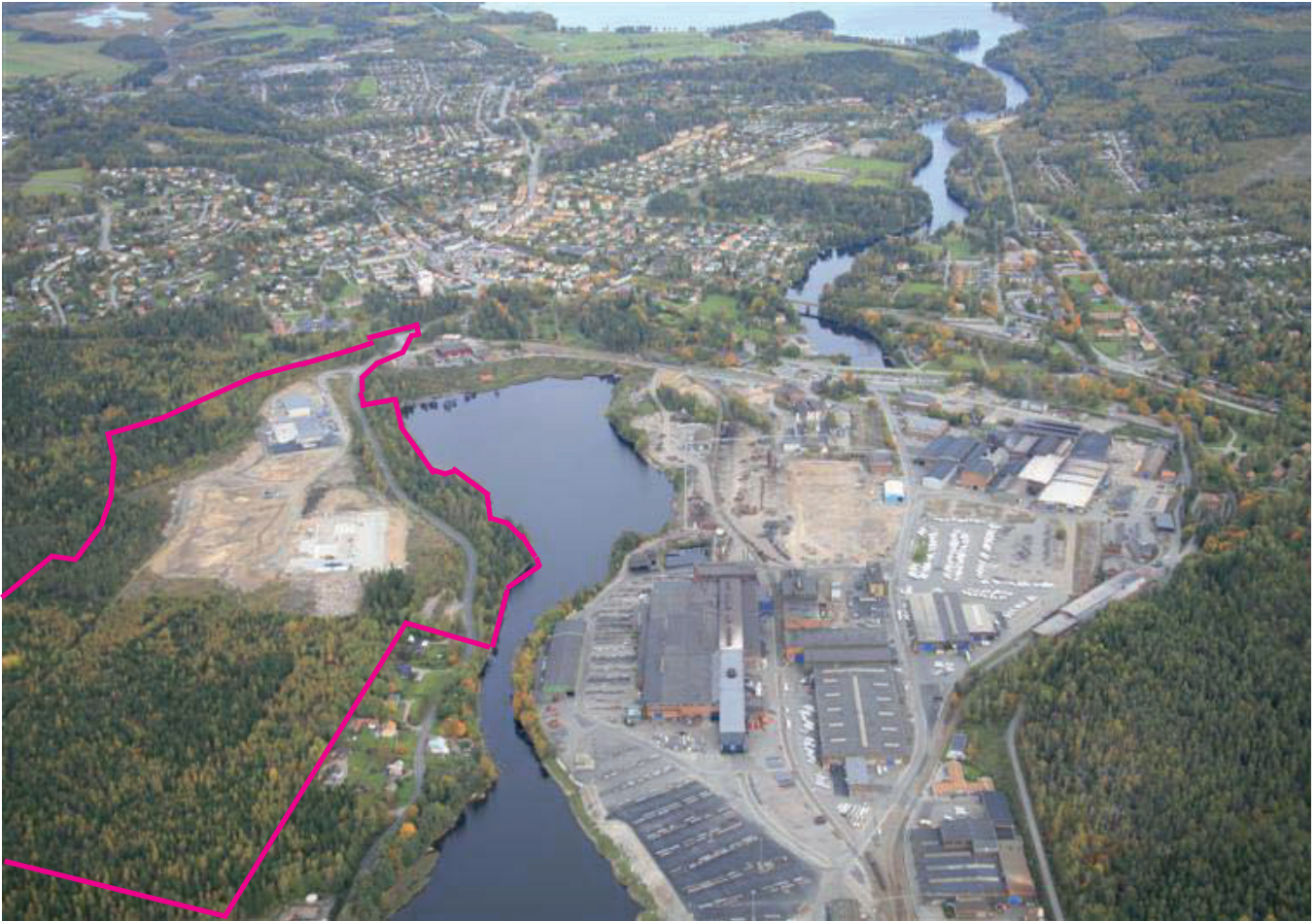
Flygbilden är tagen från söder mot norr och visar planområdets ungefärliga avgränsning markerat med rött. Planområdet fortsätter ett stycke utanför bildkanten mot väster (vänster på bilden). Till höger i förgrunden ligger Degerfors Järnverk som är avskilt från planområdet av Agsjön och Letälven. I bildens övre del kan i princip hela Degerfors tätort ses. Bilden är tagen runt 2010.
