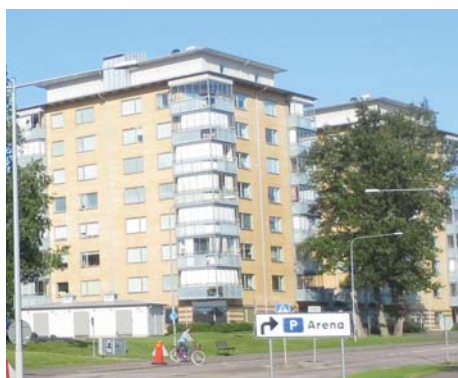
Befintliga byggnader sett från Norra Bergvägen.
