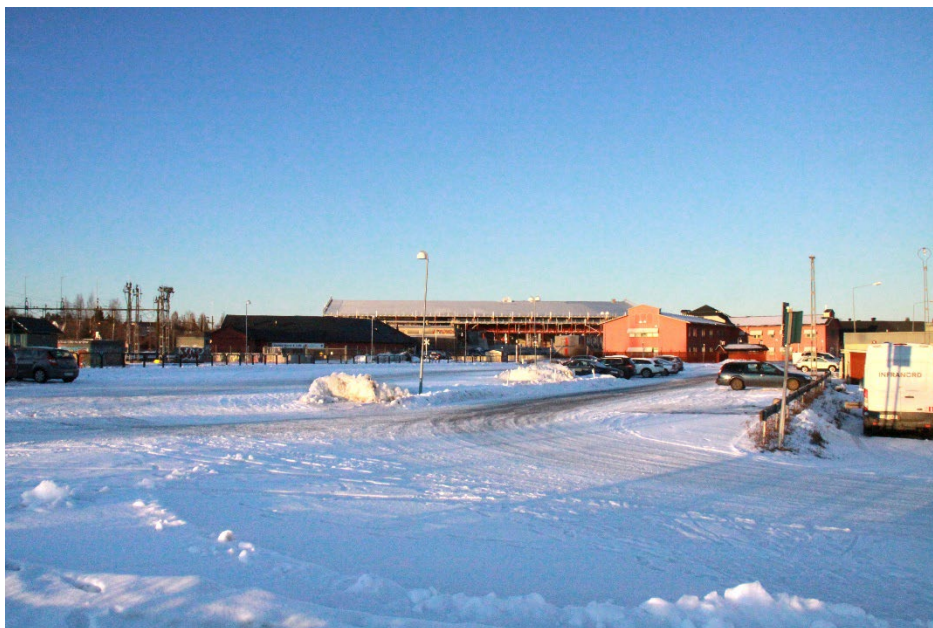
Figur 8. Parkeringsytan mot Järnvägsgatan.
