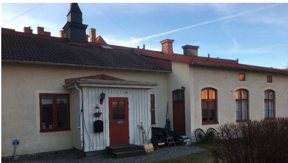
Gårdshusen inne på fastigheten Rättstjärnan 9.
