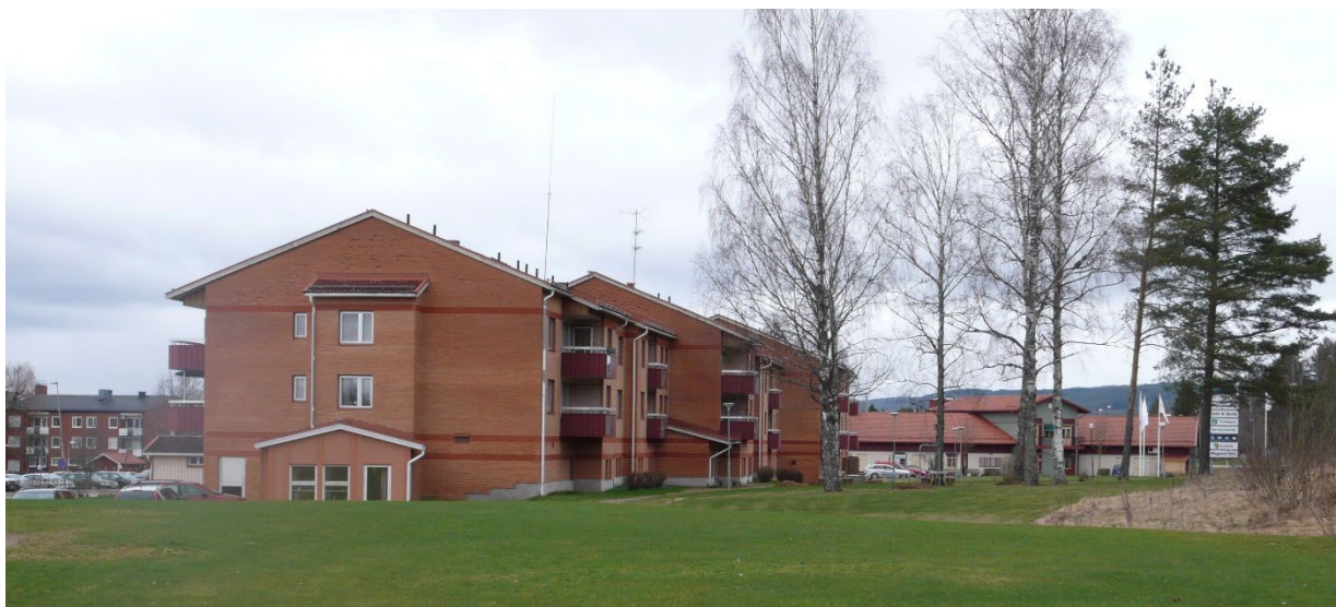
Byggnaden sedd från söder
