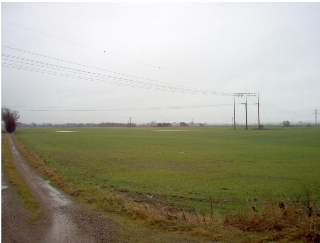
Bild 7. Vy österut från Parallellvägen, avgreningspunkten för 50 kV-ledningarna
