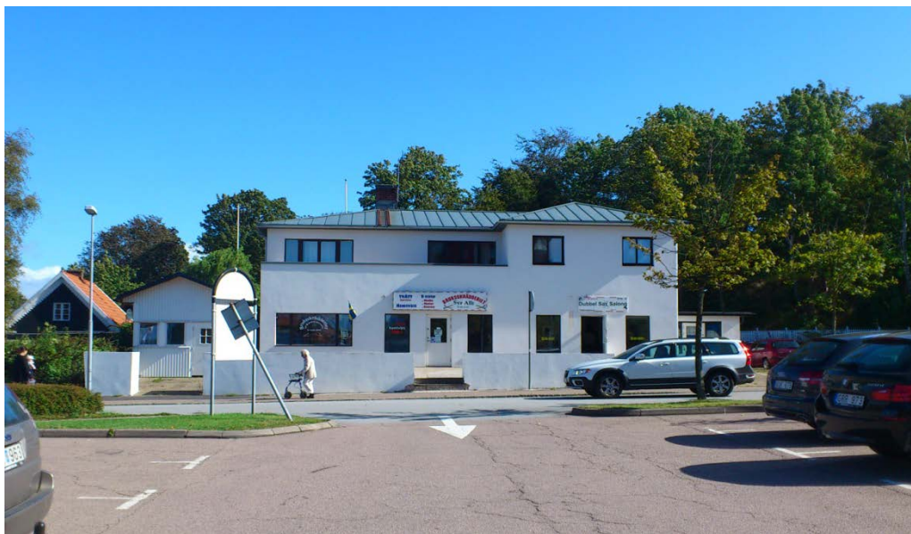
Brorsbacke Östra 6, sett från parkeringsplatsen på Västra Parkgatan
