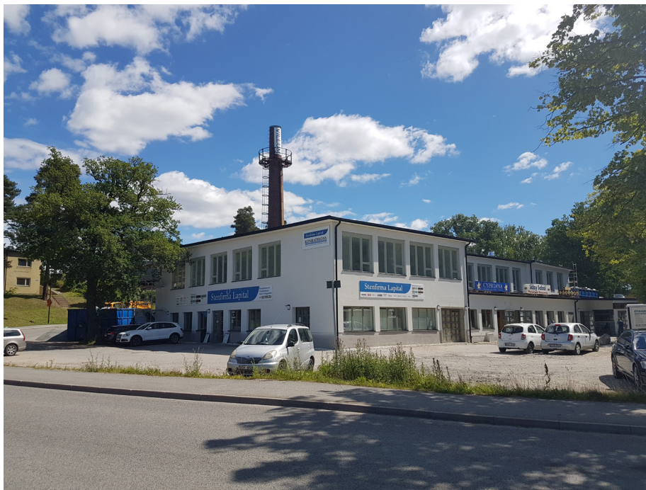
Befintlig byggnad med tillhörande industriskorsten på norra delen av fastigheten Säby 3:69. Denna byggnad ges skydd i förslaget till ny detaljplan enligt 8 kap. 13, 14, 17 §§ Plan- och bygglagen.
