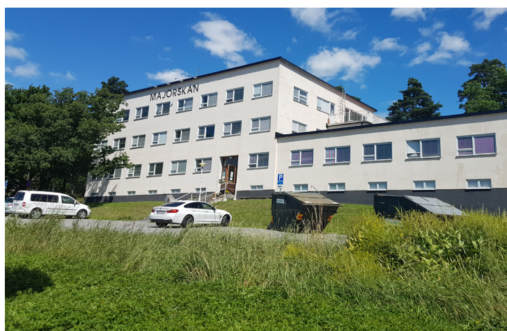
Majorskan är den mest utmärkande byggnaden i den militärhistoriska bebyggelsesmiljön.
