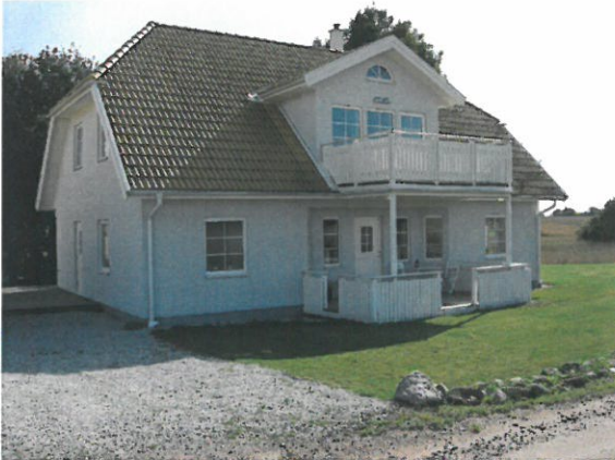
Fig. 11. Hus byggt 2004 på fastigheten Nedra Glumslöv 12:4.
