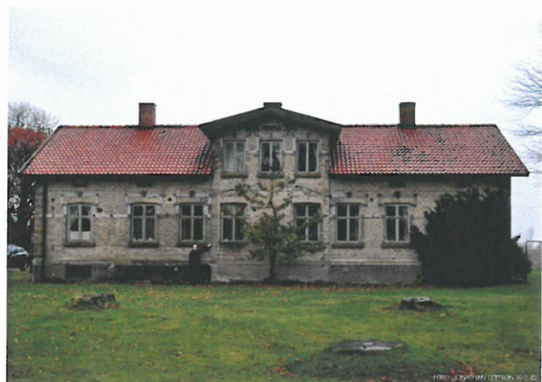
Fig. 26. Fasad mot norr på Strandnäs gård. Foto Jonathan Gertson 2011 ©.
