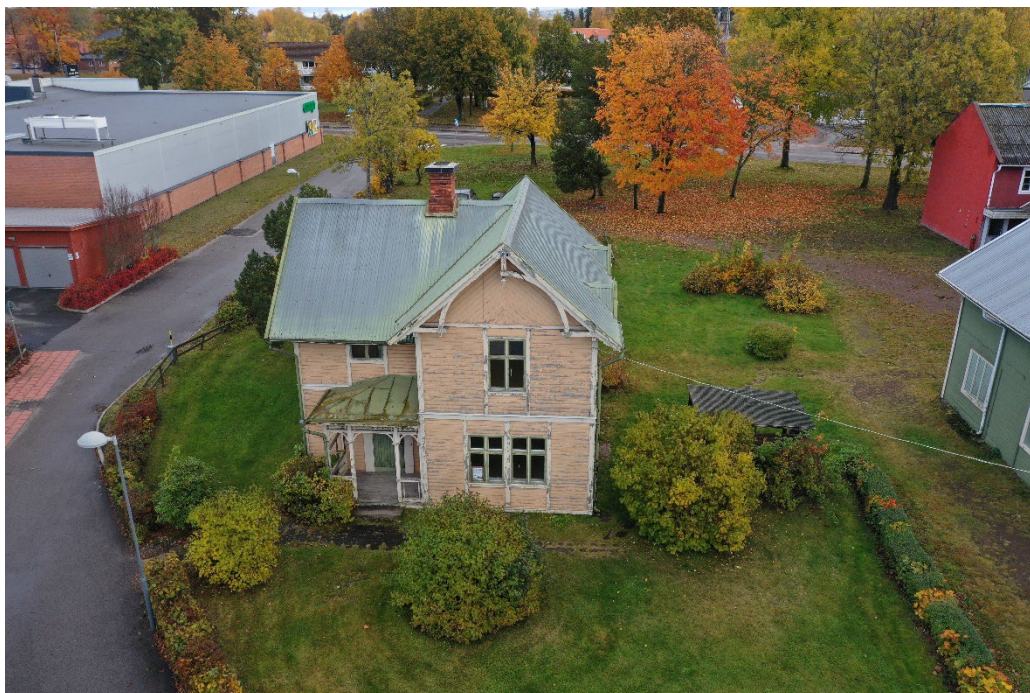
Ottosonska villan. I bilden syns den vinkelställda byggnaden med sitt sadeltak, byggnadens gula fasad med vita knutar och detaljer, fönster och fönstersättning, farstukvisten, skorsten och takutsprång över fönster på andra våningen.
