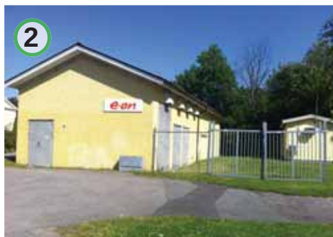
Fördelningsstationen är central plats för Kungsbackas ledningar och ligger kvar i området.
