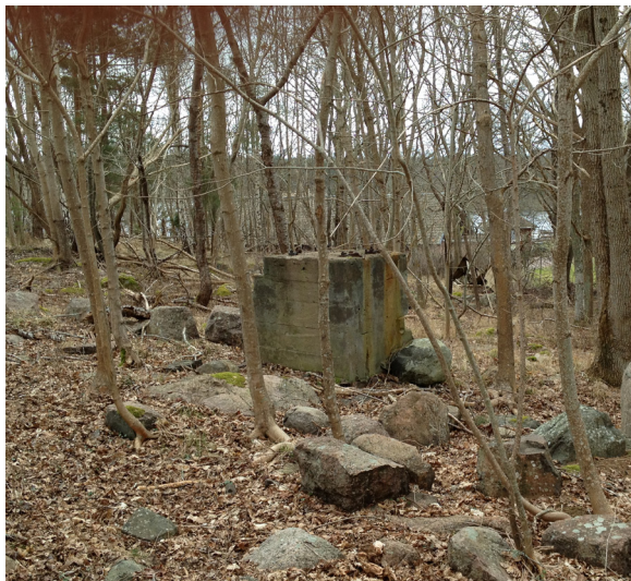
Bild 3. Ett betongfundament, spår efter den numera nedlagda varvsverksamheten.
