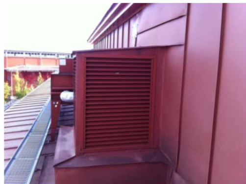
Ljuddämpande åtgärder krävs för utblåst LB2, kommunhusets tak.
